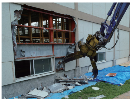
写真2: 従来技術におけるラスモルタル撤去状況
