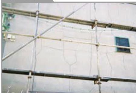
ひび割れの拡幅作業
