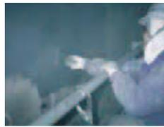
全壁面を高圧水洗浄後タケモルフィラーをローラー、刷毛、吹き付け等で塗布する。
