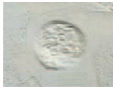
座掘り部、ひび割れ拡幅部をブローヤや刷毛等で清掃し、タケモルフィラーを塗布後、SBR系ポリマーセメントモルタルで面に埋め戻す。
