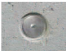
TMワッシャーを介して専用ビスでモルタル座掘り部を受け部材に定着させる。
