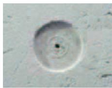
座掘カップを使用し、露出した既存モルタル面を下穴を中心に径50mm、深さ5mm程度に座掘りする。
