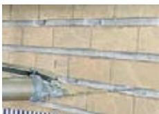
ピンニング孔並びに一文字溝をブローで清掃し、ジャピナエポを穴底から注入する。
