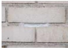
タイルガード頭部の湾曲部空間へジャピナエポを充填し、タイルとタイルガードとの一体化を図る。
