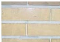
既存目地材の色に合った市販目地モルタル材を、ジャストロン希釈液で混練し、タイルガード設置跡を修復する。
