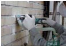
タイル4枚(いも目地)または3枚(うま目地)の目地交点に躯体に25mm以上届く穴をあける。Uカット用サンダーを用いて目地交点を中心に一文字溝を刻設し、完全にタイルの小口面を削り出す。
