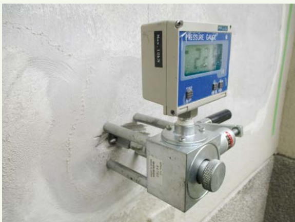
ガードピンの引抜試験状況
