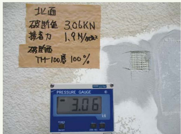
ネット入りモルタルの接着力試験状況
